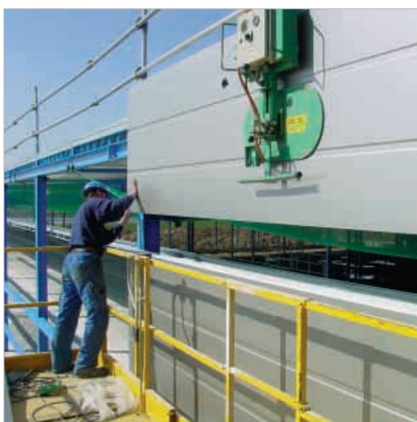
Montage met behulp van vacuüm-apparatuur
