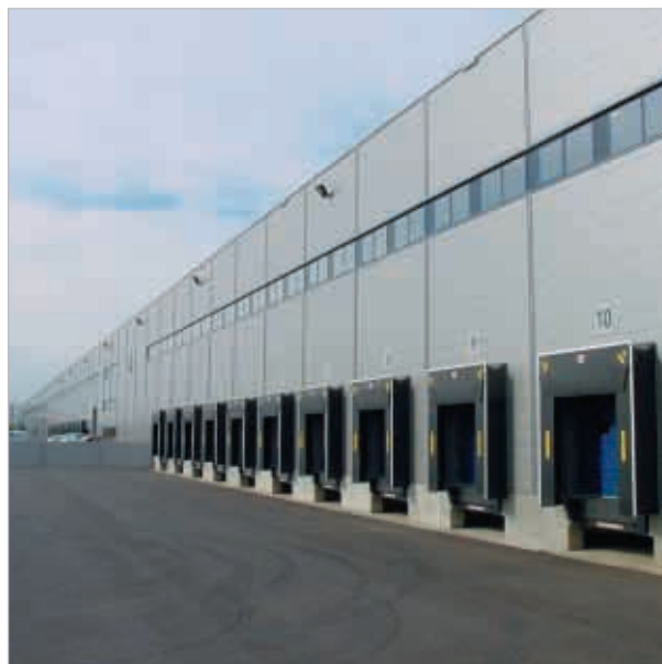
IFD-bouwen met staalsandwich gevelpanelen
